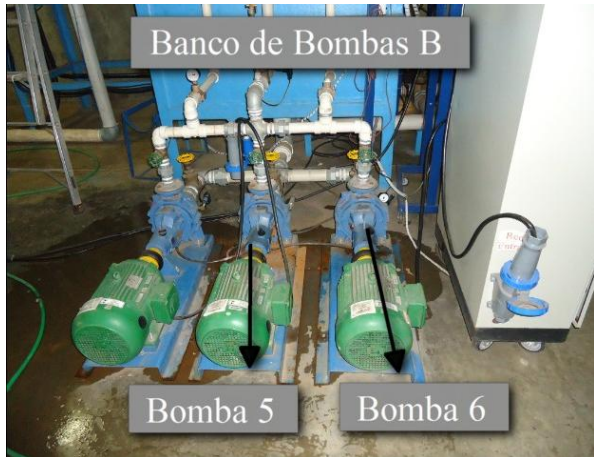
Fotografia 2. Banco de bombas B
