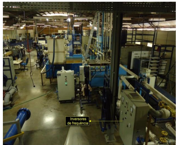
Fotografia 5. Inversores de frequência da elevatória
